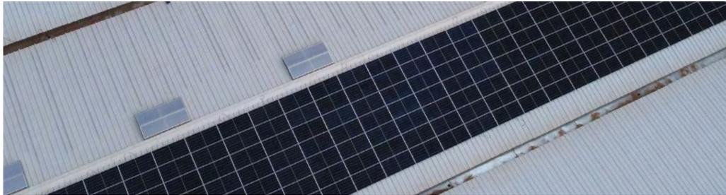
Se han instalado **paneles solares** en las **nuevas edificaciones** con el objetivo minimizar las emisiones contaminantes, conseguir un ahorro energético considerable y disminuir el ruido ambiental. 500Kw de paneles solares para generar una producción estimada de 867 MWh/año en régimen de autoconsumo.
